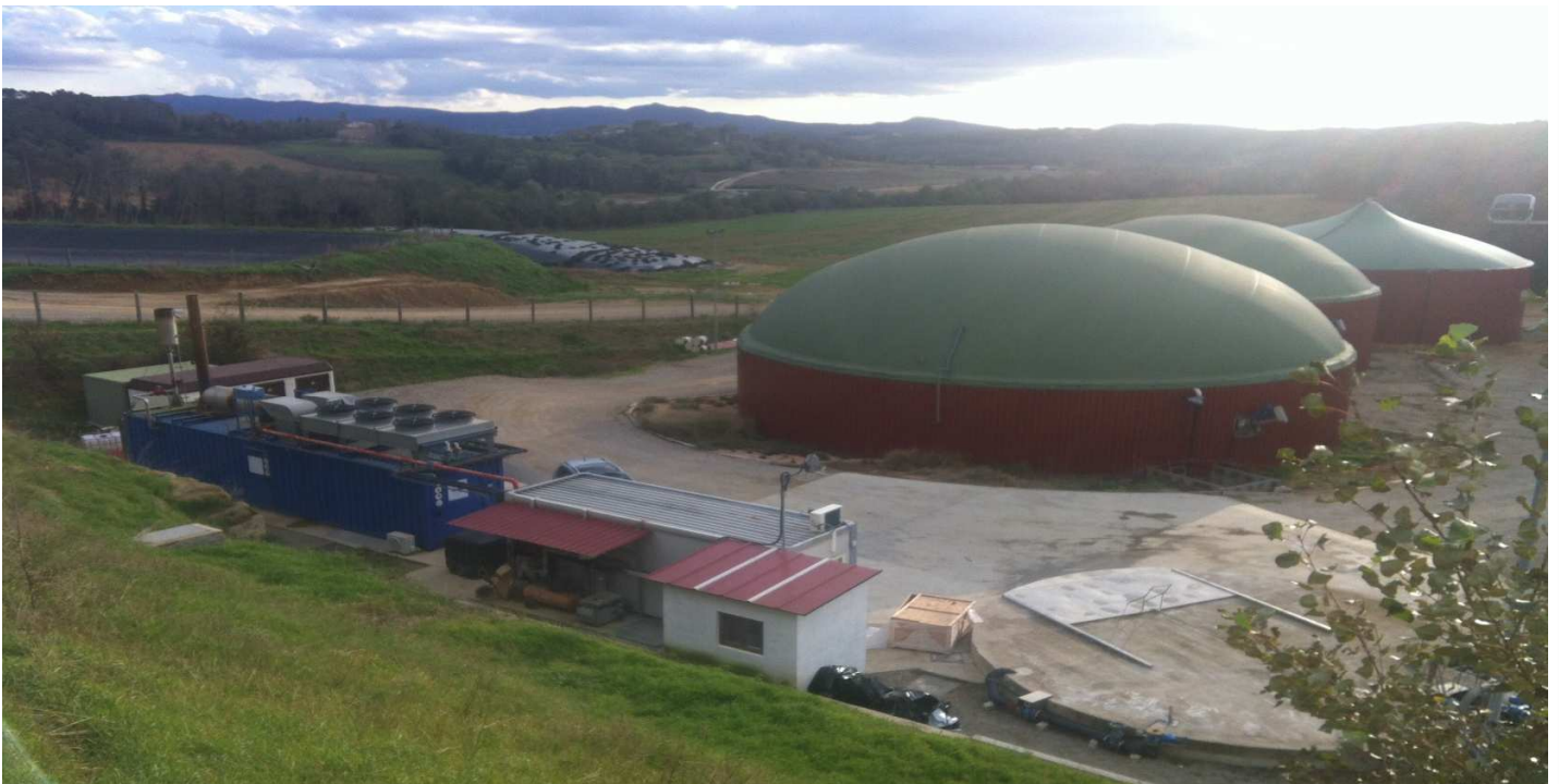
Planta de digestió anaeròbia de la granja SAT Sant Mer.
