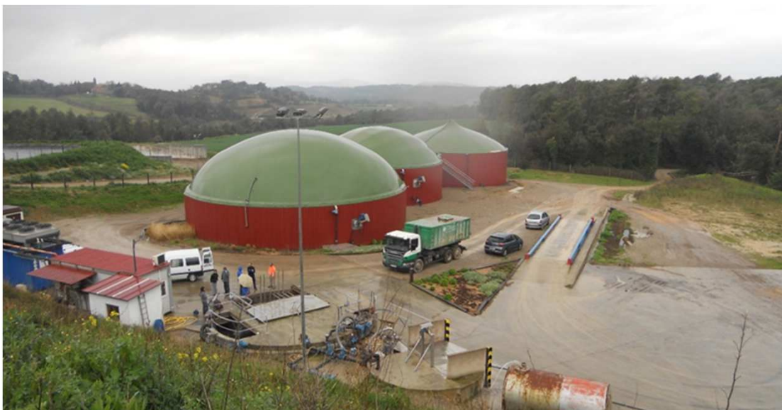
Planta de biogàs Aspergas. S'observen els tres reactors on es produeix la digestió anaeròbia dels purins.
